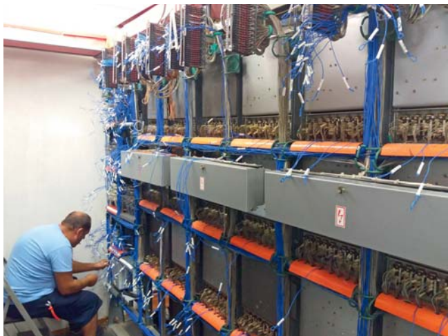
Bükkösd állomás KÖFI illesztés építése (Fotók: Szita Szabolcs, Tarjányi Zoltán)
