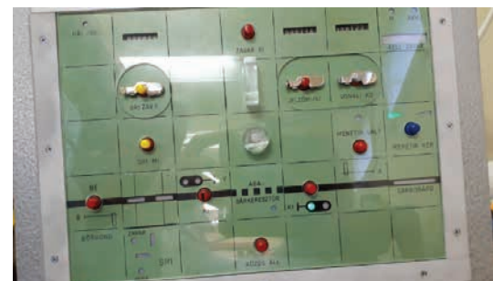
4. kép: Aba-Sárkeresztúr, ellenmenet-kizáró biztosítóberendezés
