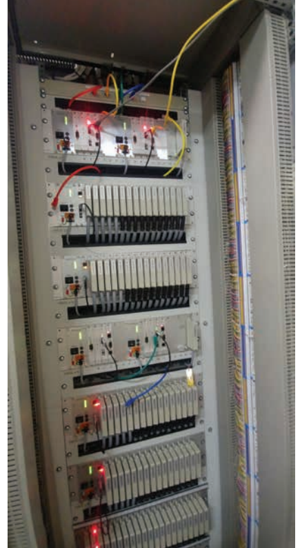
3. kép: Pincehely állomás ELPULT berendezése
