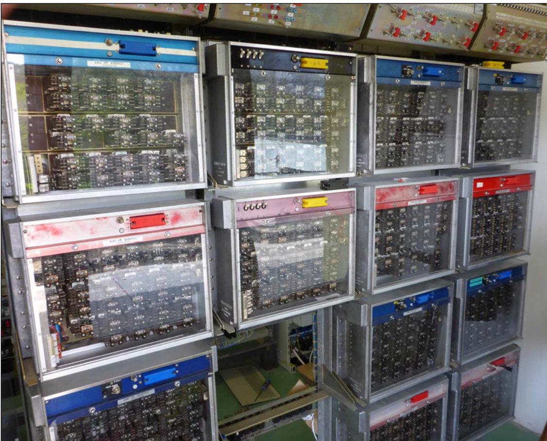
Bild 1: Komponenten des Relaisstellwerks Domino-70
