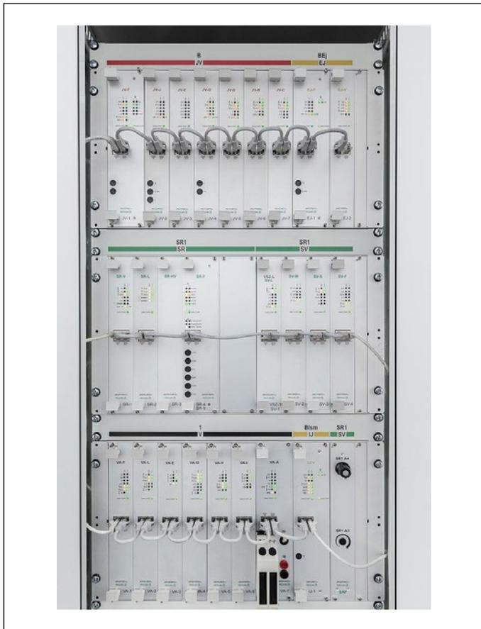
**Bild 6: JM18-Frontplatte mit farbigen Informationsbalken**
