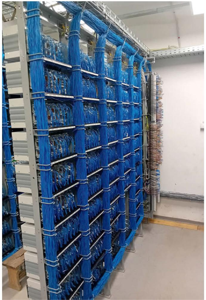
**Bild 5: Hinterseite der Relaisgestelle, mit exzessiver Einzelverdrahtung**
