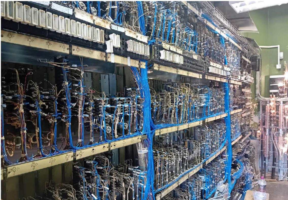
**Bild 1: Die alten Relaisgestelle mit – sehr oft modifizierten – Verdrahtungen**
