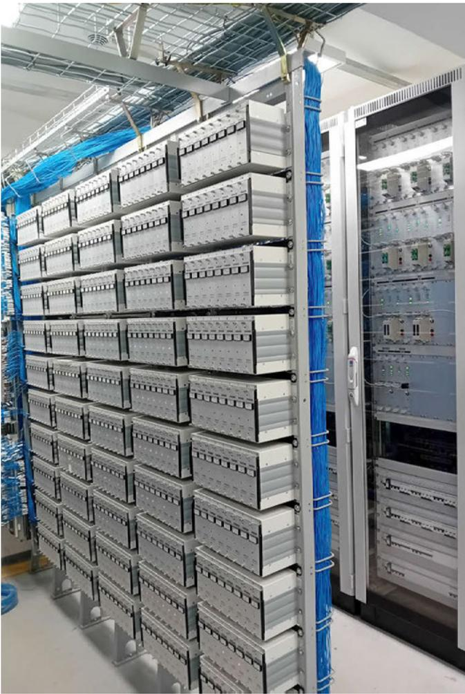
**Bild 4: Relaisgestelle mit Schnittstellenrelais, PRORIS-H im Hintergrund**
