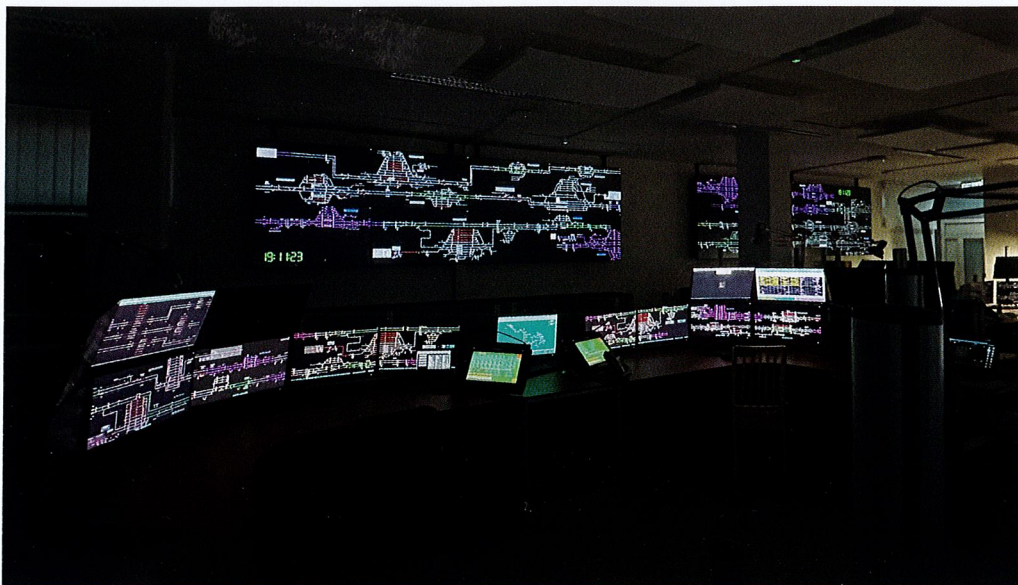
A hegyeshalmi vonal Elpult/AKF visszajelentő felülete (panorámatábla)
