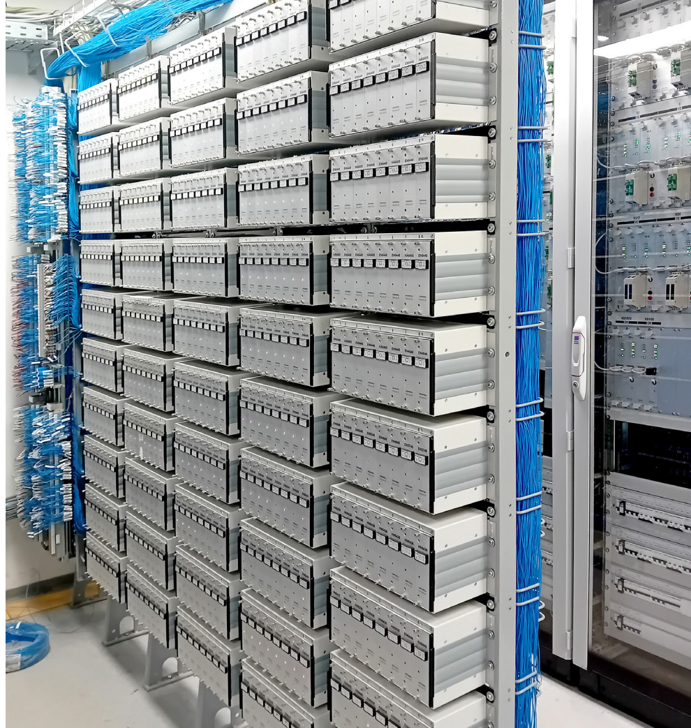
Relaisgestellen mit Schnittstellrelais, PRORIS-H im Hintergrund
