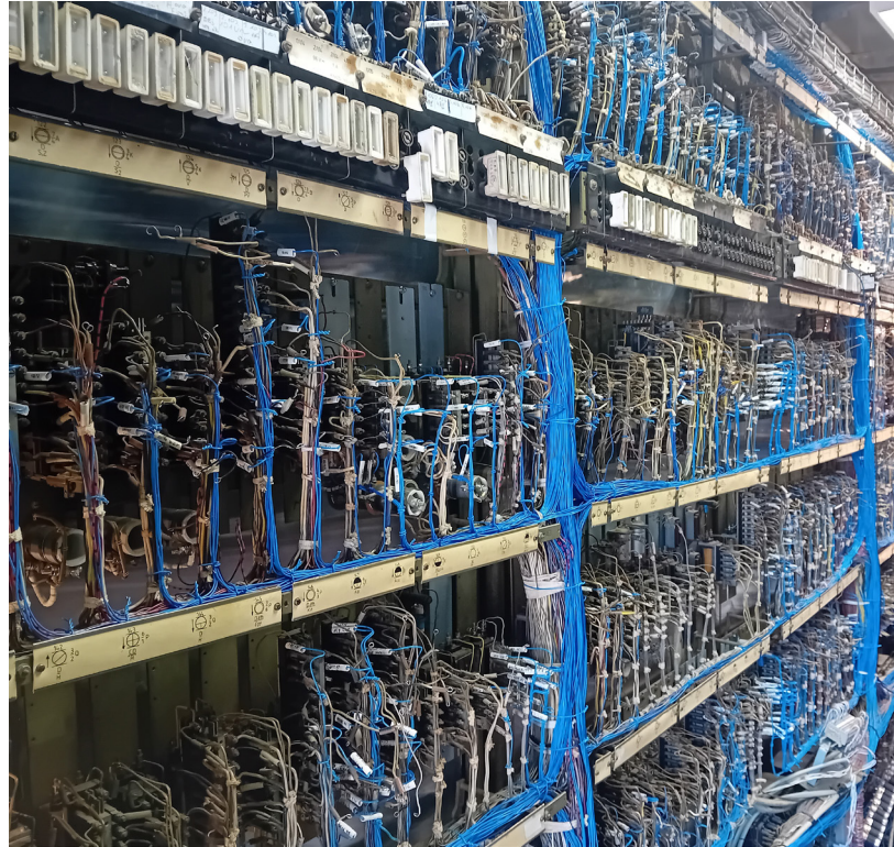
Die alte Relaisgestellen mit – sehr oft modifizierte – Drahten
